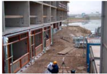
jan '06 - Plaatsing gevelpuien
