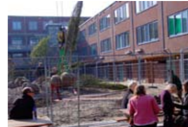
apr '07 - Aanleg binnentuin
