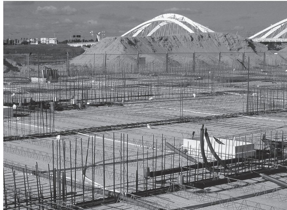
September 2005: Betonvlechtwerk keldervloer
