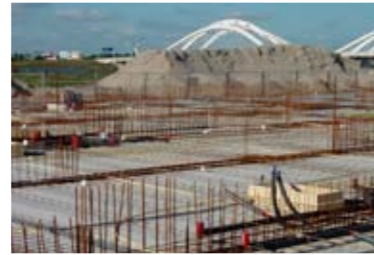
sept '05 - Bereiken beganegrondvloer
