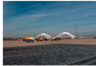
mrt '05 - Start bouw
