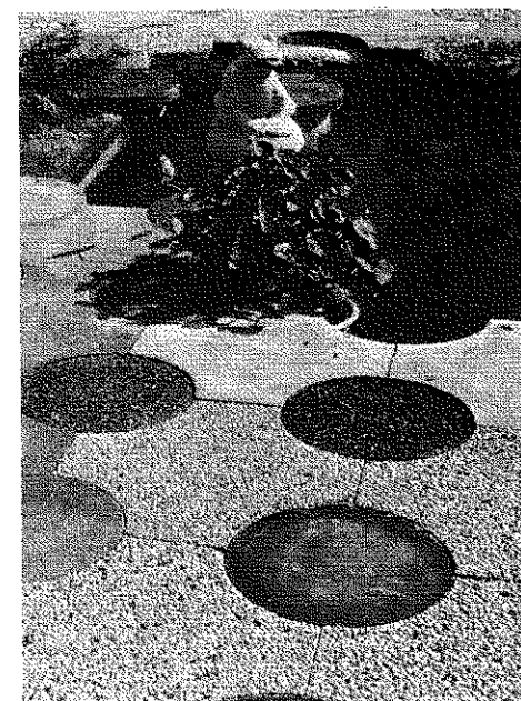
Fig. 2.06.w. Betontegels 50 \times 50 met ronde hoekvullingen.
